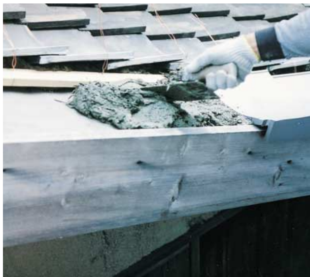
屋根土への再利用の状況
